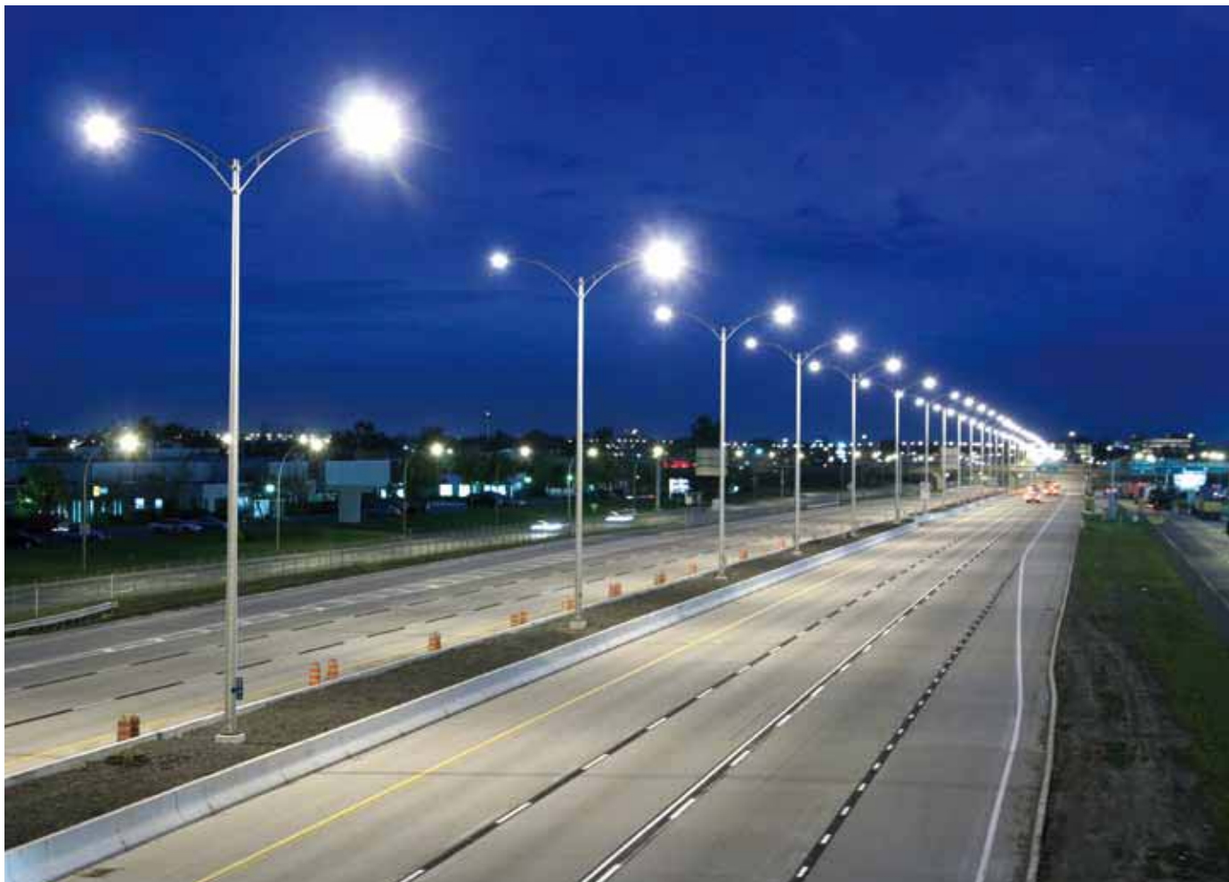
Energiahatékony útvilágítás (csökkentett fényárammal a csúcsidőkön kívül)
