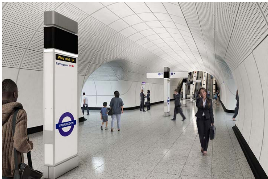
A felfelé sugárzó IKON lámpatesteket az útbaigazító oszlopok tetejére szerelték, hogy a mennyezet segítségével megvilágítsák az egész területet. Az oszlopok oldalaira és elejére szerelt IKON EMERGENCY lámpatestek áramkimaradás esetén automatikusan gondoskodnak a megvilágításról.
