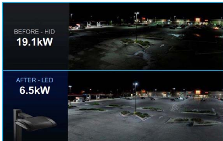
2.3 ábra – A Cree „Edge Area Square” térvilágító lámpatestei az Edgewater-i piacon (Forrás: John Edmond, Cree Inc., SSL R&D Workshop, San Francisco, CA, 2015. jan. [9])
