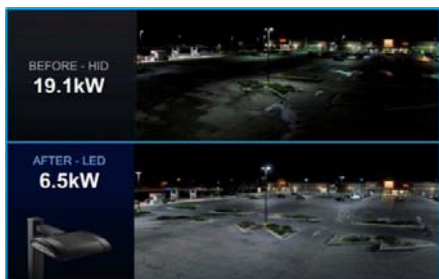
2.2 ábra – A Cree „Edge Area Square” térvilágító lámpatestjei az Edgewater-i (Kolorádó) piacén (Forrás: John Edmond, Cree Inc., SSL R&D Workshop, San Francisco, Kalifornia, 2015. jan. [11])
