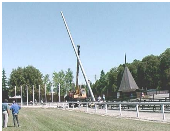
A szilvásvárad i lovaspálya fényvető oszlopainak felállítása
